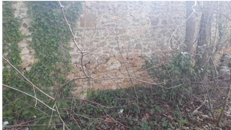
Photo 4 : Muret présent sur le site
